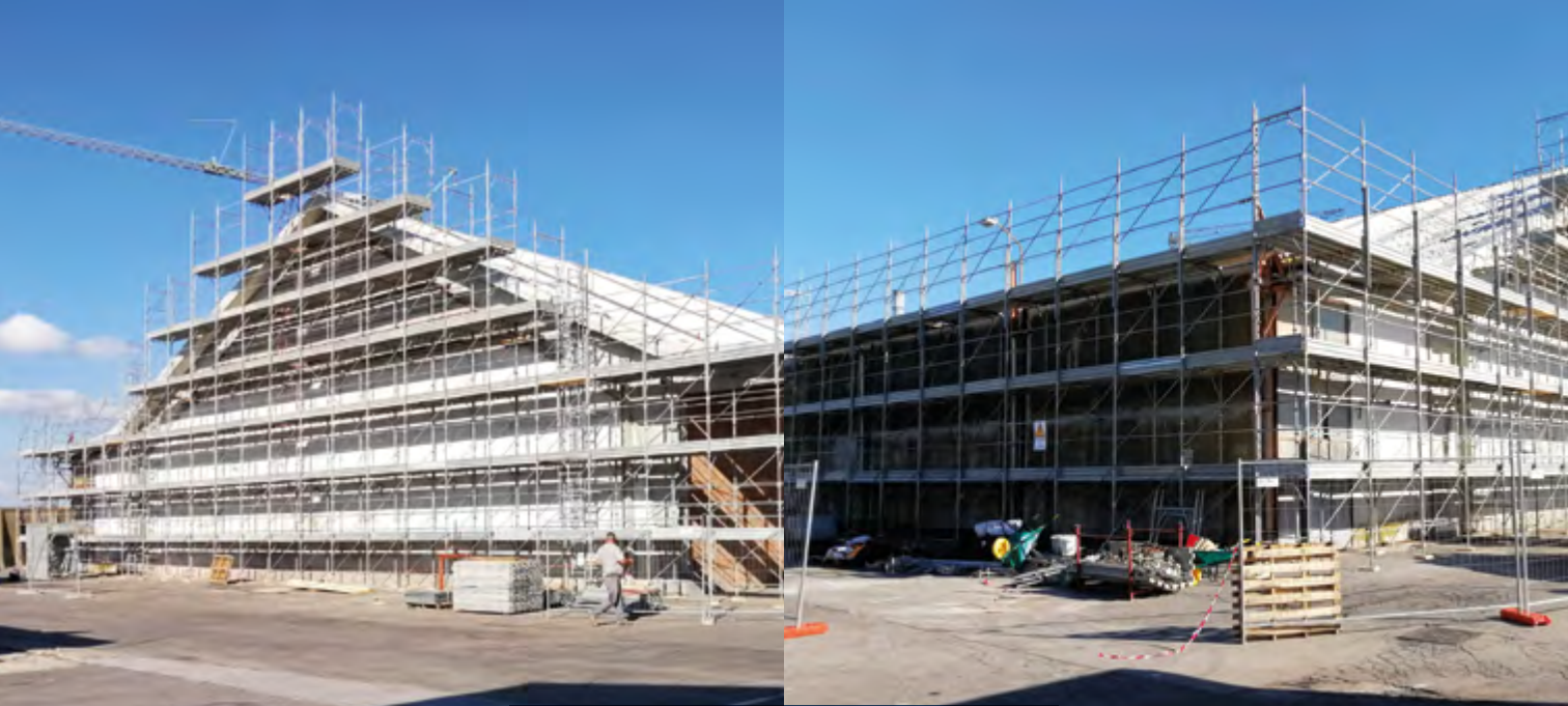
Manutenzione straordinaria di coperture industriali.
